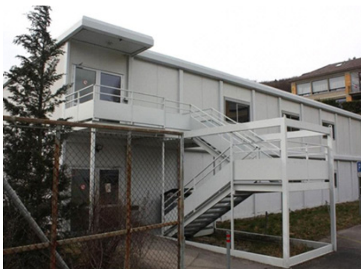
La structure en partie mise à disposition de L'Amar. SP
